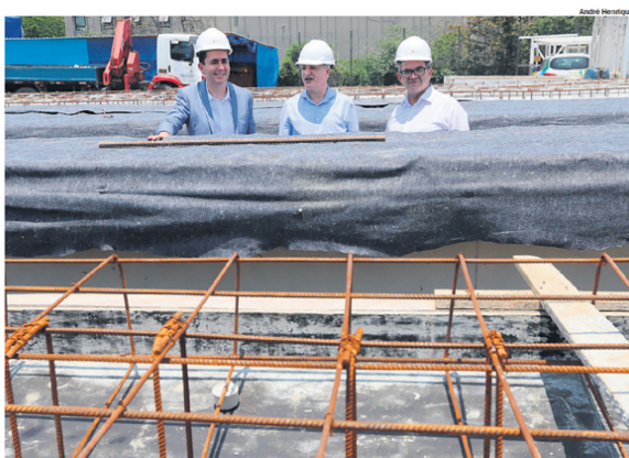
MUDANÇA. Viaduto ficará interditado por 20 meses para obras de revitalização e reforço estrutural
