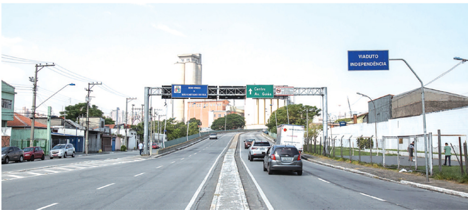
DESDE a sua construção há quase 50 anos, o importante viaduto da cidade nunca teve grandes obras de manutenção. Maior parte da obra vai acontecer no período noturno
