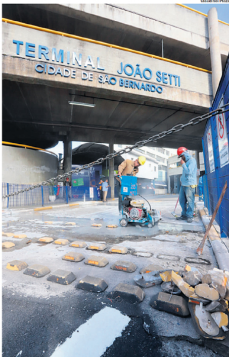
OBRAS. Funcionários, nessa quinta-feira, durante intervenção no local
