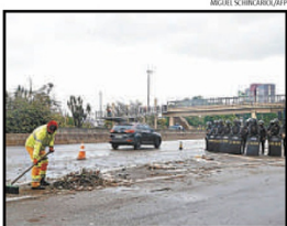
Funcionário limpa estrada paulista desobstruída ontem
