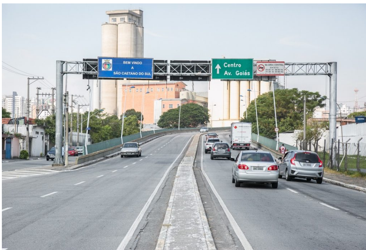
Viaduto liga os bairros Santa Paula, Santo Antônio e Centro ao Bairro da Fundação e a São Paulo – Foto: Letícia Teixeira/PMSCS
