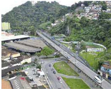
Será o primeiro restauro de grande porte desde sua inauguração
