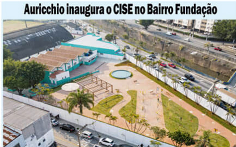
O novo Cise está localizado na Rua Ceará, 515, bairro Fundação
