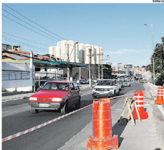
INFRAESTRUTURA. Obras na Avenida dos Estados, em Santo André
