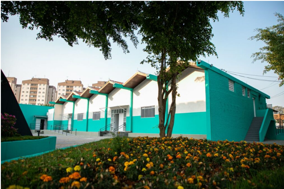
Novo CISE Sueli Nogueira, no Bairro Fundação – Foto: Letícia Teixeira / PMSCS
