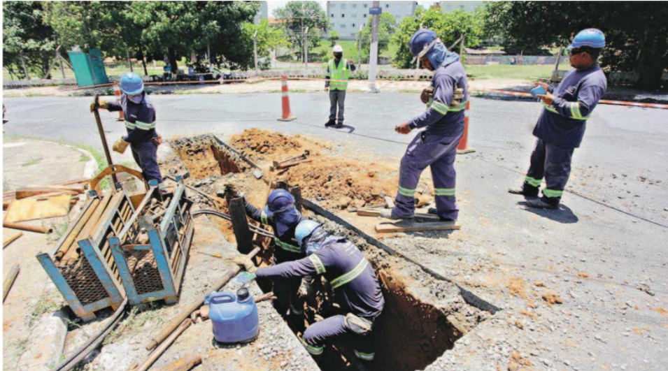
Trabalhadores da Sanasa realizam substituição da rede de água por meio de um método menos destrutivo. Campinas está à frente de algumas capitais em investimentos públicos
