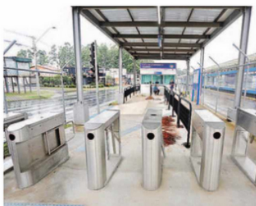
Estrutura do BRT Campo Grande está pronta para receber passageiros
