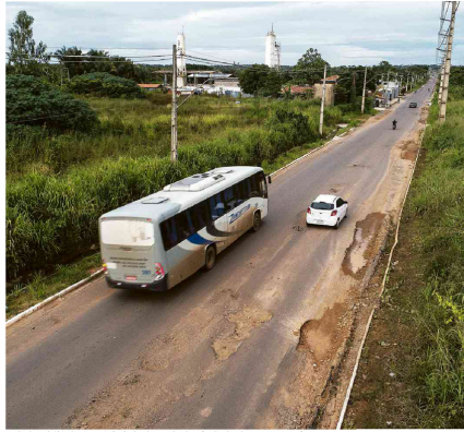
Trecho do asfalto em Itapetininga (MA), obra da estatal Codevasf realizada pela construtora Engorf...
