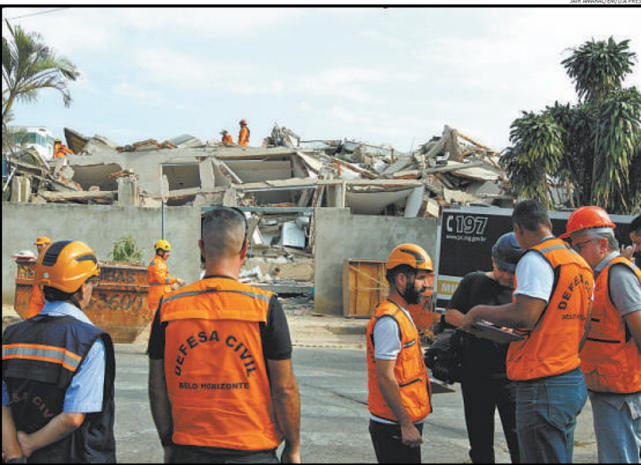
Enquanto bombeiros percorriam escombros em busca de vítimas, agentes da Defesa Civil chegaram para vistoriar estrutura que ruíu e imóveis vizinhos
