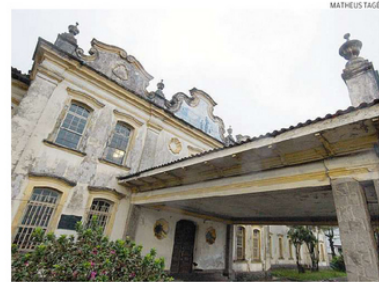
O imóvel foi, até 2018, a sede de uma escola técnica estadual (Etec)
