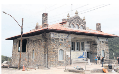
MONUMENTOS. Pouso de Parapiacaba, uma das construções de 1922, está sendo restaurado
