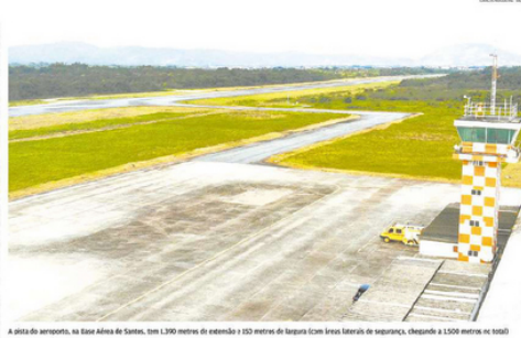
A pista do aeroporto, na Base Aérea de Santos, tem 1.300 metros de extensão e 100 metros de largura (com faixas laterais de separação, chegando a 1.500 metros no total)
