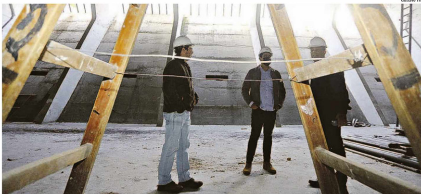
Engenheiros observam o andamento das obras de restauro das estruturas internas do Centro de Convivência Cultural, que será reaberto ao público aos poucos
