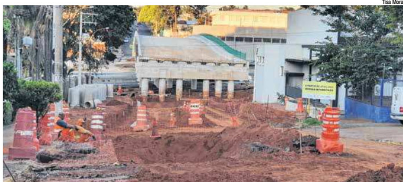
Estão sendo executados serviços de drenagem, terraplanagem e fabricação de muros de arrimo
