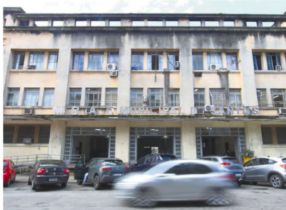
As obras compreendem três fases: a segunda será no interior do Mercado e a terceira na Bacia do Macuco
