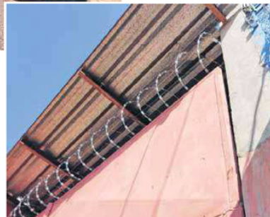
Cerca tipo concertina foi instalada em espaço entre portão e telhado, após furto
