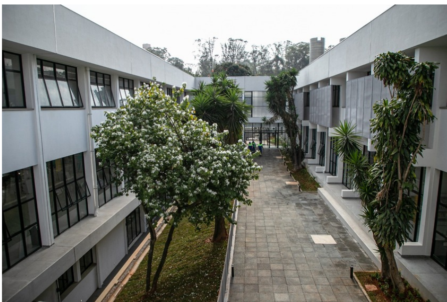
Com aporte de R$ 21 milhões, essa é a maior obra da Prefeitura em termos de volume de construção e recursos investidos na área da Educação. Foto: Divulgação
