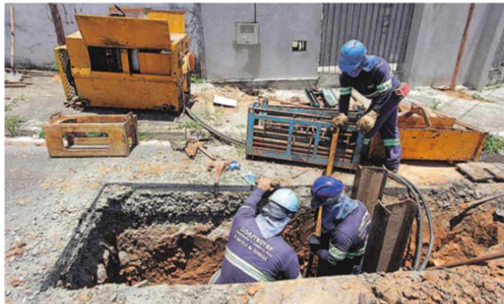
Com as obras, Administração quer evitar o desperdício de água na distribuição, provocado por vazamentos
