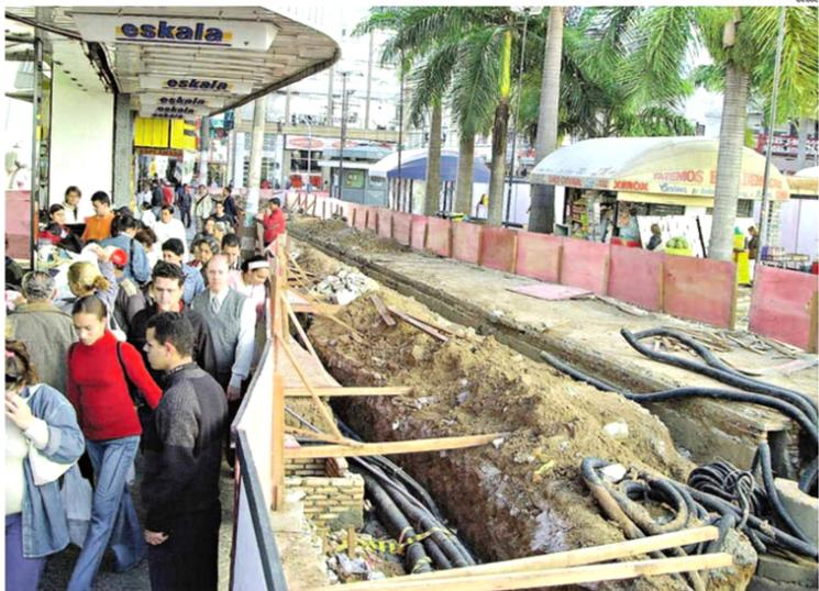
Nas obras da Rua 13 de Maio em 2003, todos os cabos de energia elétrica foram enterrados sob o calçadão, para remover a fiação que ficava suspensa
