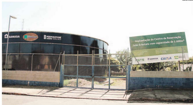
Centro de Reserva João Erbolato, com capacidade para 2,5 milhões de litros de água, beneficiando aproximadamente 23 mil pessoas
