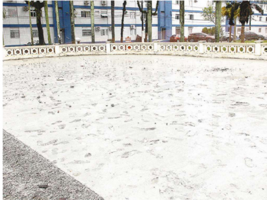
Em junho, vândalos pisaram no cimento fresco de uma praça no Aparecida que estava sendo revitalizada
