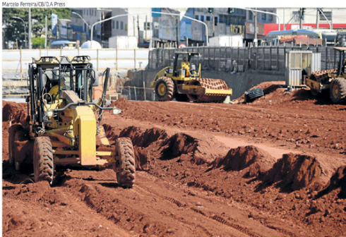
As máquinas pesadas ainda estão trabalhando no canteiro de obras
