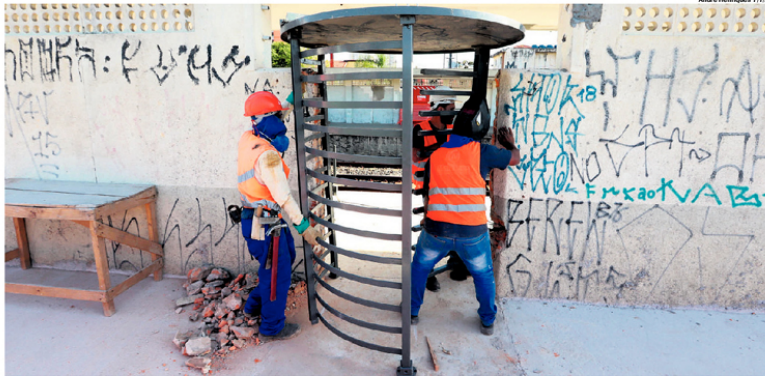
OBRAS. Funcionários trabalham em um dos locais de passagem de usuários da estação Utinnga, em Santo André, que faz parte da Linha 10 - Turquesa
