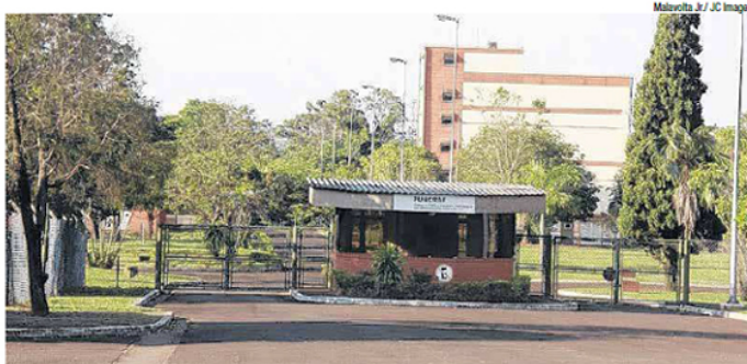
A entrada do imóvel que, no passado, foi utilizado como sede administrativa pela instituição
