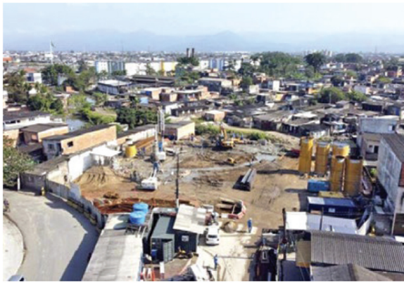
Mais da metade das 121 estacas da etapa final de fundação estão prontas na Zona Noroeste
