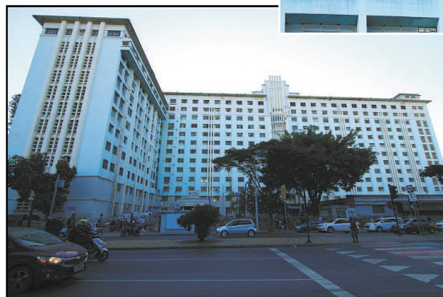
Vista da Santa Casa e janelas quebradas durante o incêndio; Polícia Civil abriu inquérito para apurar o que provocou as chamas e a instituição também anunciou que vai contratar perícia nas áreas atingidas
