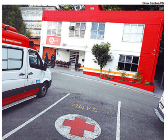
REMODELADA. Sede do Samu recebeu pintura interna e externa
