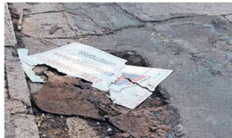
Placa de madeira lançada sobre um buraco a fim de diminuir o impacto de veículos
