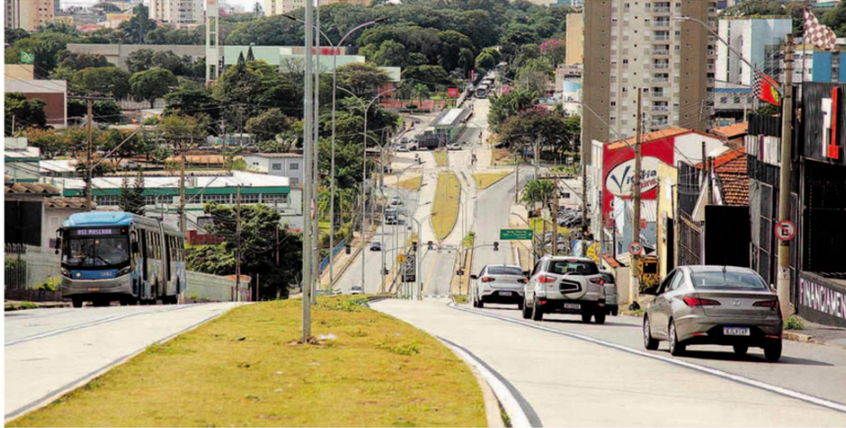
Movimento de veículos na Avenida das Amoreiras, onde está instalado o BRT: via está sem radares desde o início das obras e deverá receber equipamentos para controle de velocidade
