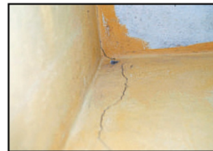
Uma trinca de 1,5m surgiu em residência no Bairro Vale das Palmeiras depois dos abalos, de acordo com o proprietário
