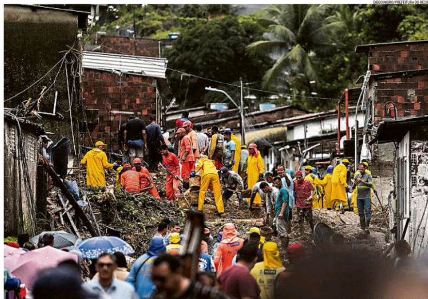
Tentativa de resgate. Equipes procuram sobreviventes nos escombros de uma casa em Jardim Monte Verde, comunidade no limite entre Recife e Jaboatão dos Guararapes
