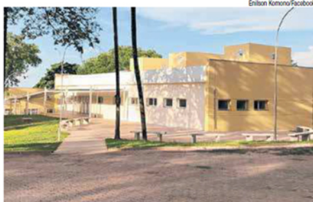
Hospital Manoel de Abreu, na VI. Souto, passou por ampla reforma
