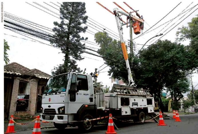
Equipes da empresa realizaram manutenção em equipamentos da Rua Dr. Pereira Neto, na zona sul da Capital, no dia 11
