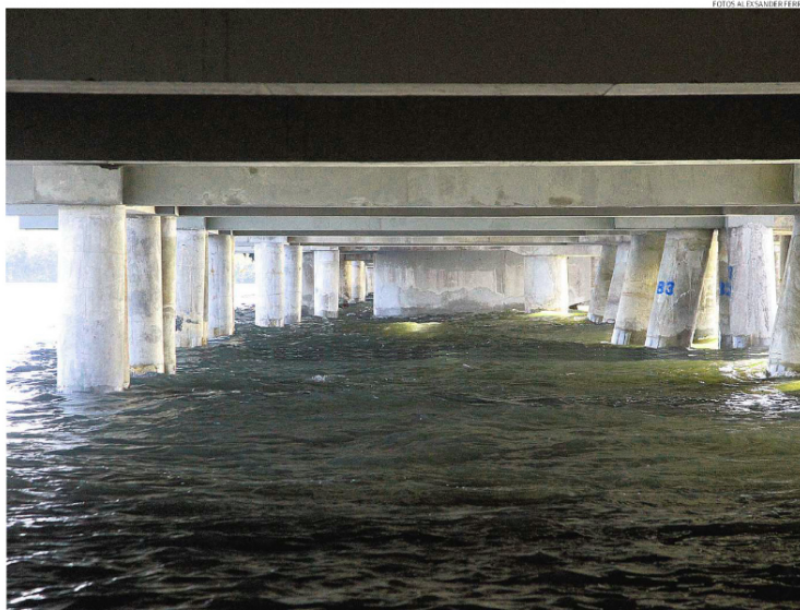
Uma das etapas mais importantes já foi finalizada. Todas as 217 estacas, que necessitavam de reparos, já foram recuperadas nos trabalhos
