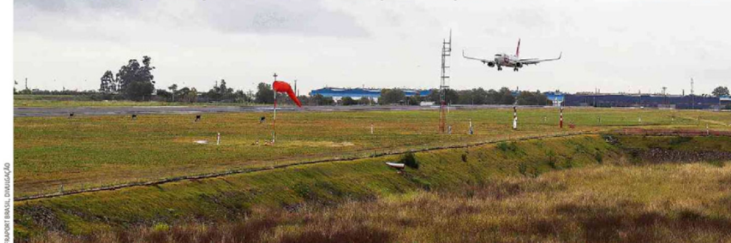
Trecho a mais de 920 metros foi liberado e área está apta para receber aviões de grande porte, com promessa de destravar gargalo logístico
