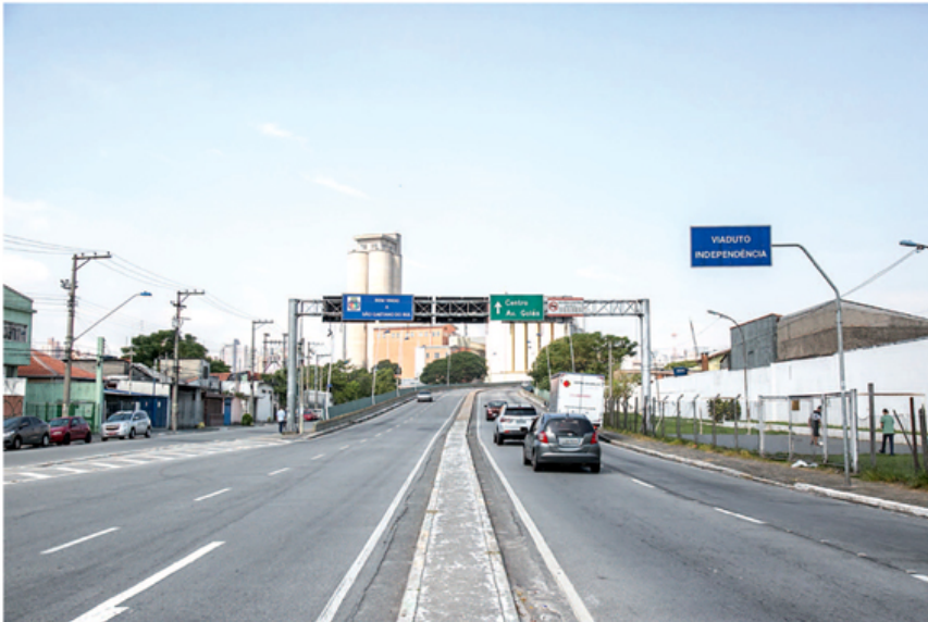
OBRAS no Viaduto são necessárias há muitos anos. Motoristas não se sentem seguros ao atravessar o viaduto pela trepidação.
