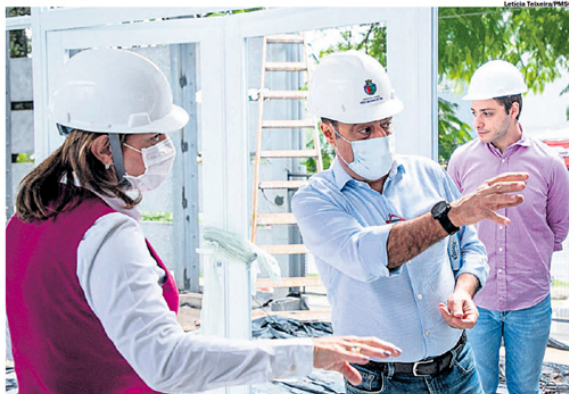
VISITA. Regina Maura, Auricchio e Thiago estiveram na obra para avaliar o andamento dos serviços
