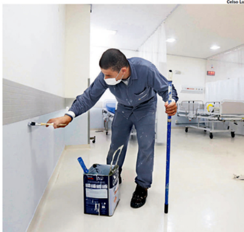
SOB DEMANDA. Equipes vão fazer reparos nas unidades de saúde
