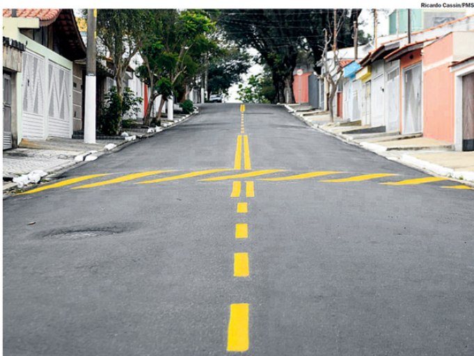
MAIS SEGURAS. Uma das vias recapeadas na região do Rudge Ramos, etapa que termina em breve
