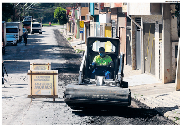
MELHORIAS, Rua Fernando Costa, no Parque Gerassi, passou por recapeamento asfáltico
