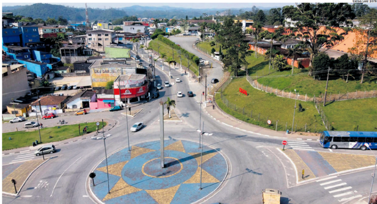
EM OBRAS. Terminal rodoviário e transferência da estação da CPTM são os dois presentes mais esperados pelos munícipes de Rio Grande da Serra
