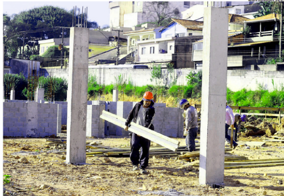
EXPECTATIVA. Obra do equipamento está em andamento e deve ser concluída até outubro de 2024
