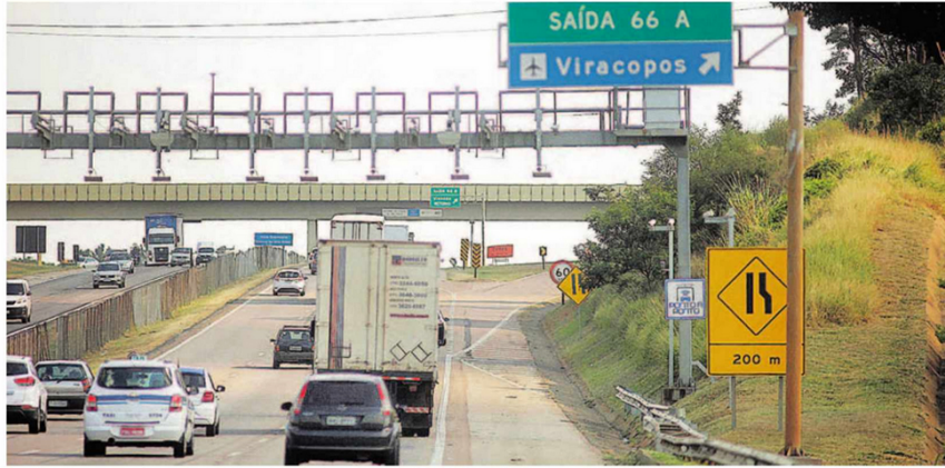
A região de Campinas recebeu o primeiro sistema eletrônico ponto a ponto do Estado de São Paulo há nove anos: foi instalado na Rodovia Santos Dumont (SP-075)
