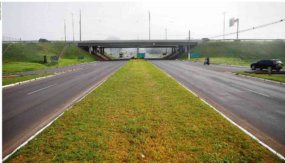
RS-118 é uma das vias que integrará o bloco 1, mas há reclamações sobre a instalação de cancelas no local
