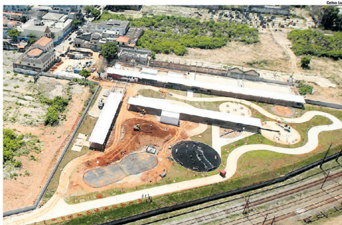
FASE FINAL. A Prefeitura já realizou no local serviços de terraplanagem, urbanização, ciclovia e pista de caminhada
