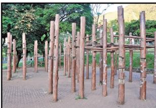
Equipamentos danificados na Praça do Papa, na Região Centro-Sul privam as crianças de espaço para diversão
